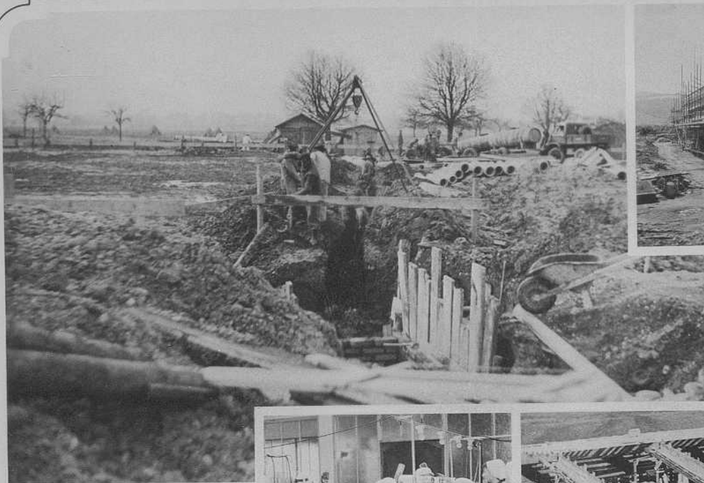
16. Januar 1955, erste Bauetappe war die Abführung des Abwassers (Kanalisation).
