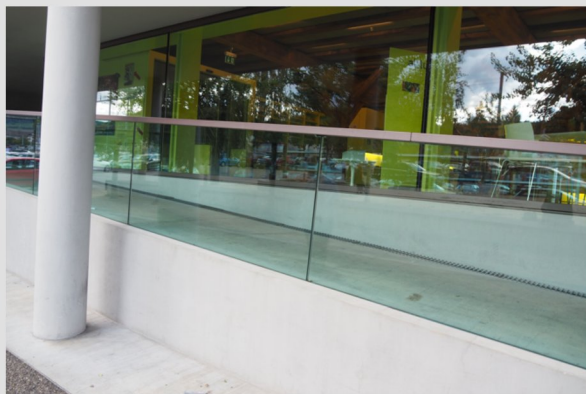
Abbildung 53: KB Liestal, barrierefreier Eingangsbereich mit Sicht in die Bibliothek
