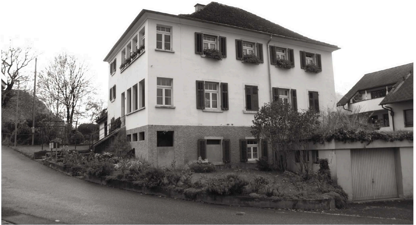
Das Alte Schulhaus in Mäls, Prär 6 (früher Haus Nr. 17). Es wurde 1919 die Idee diskutiert, dieses Gebäude zu einem Armenhaus umzubauen.
