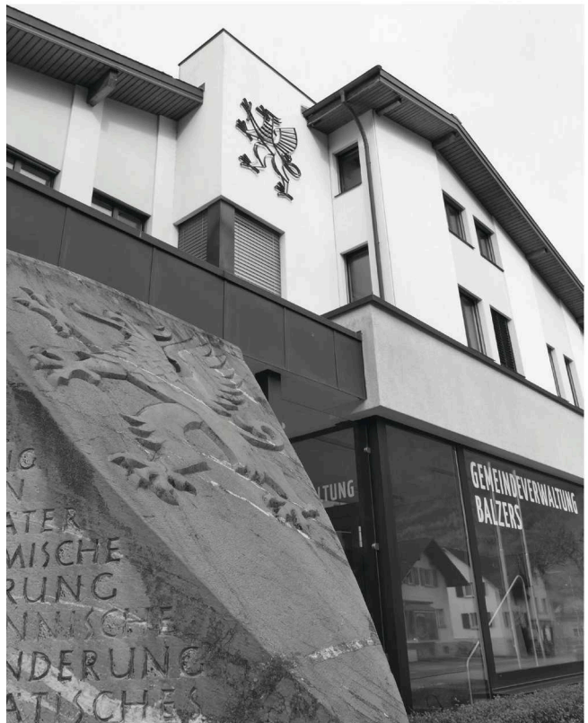
Im 1959/1960 gebauten neuen Gemeindehaus, das seither mehrere Umbauten und Renovationen erfahren hat, tagt der Gemeinderat, hat der Gemeindevorsteher sein Büro und sind die Gemeindeverwaltung und die Gemeindekasse untergebracht. Gleichzeitig ist es der zentrale Ort in der Gemeinde zum Beispiel für Gemeindeversammlungen, Informationsanlässe und kulturelle Veranstaltungen.
