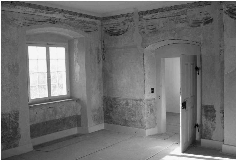
Oben: «Stube» im 1. Obergeschoss mit dekorativem Holzboden. Die Fenster-nische von Seite 21 ist jetzt geöffnet (hinten links).
