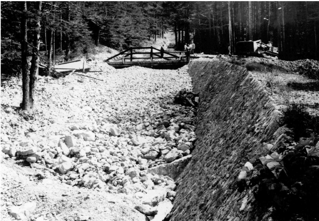
In der Balzner Rufe hat am 11. Juli 1959 ein Rufeingang bei der Brücke so stark aufgelandet, dass die Rufe oberhalb der Brücke beidseitig ausbrach. Die nördliche Brückenhälfte wurde weggeschoben. Rund 3'000 m 3 Geschiebe mussten mit Trax und Bagger aus dem Rufe lauf geräumt werden.
