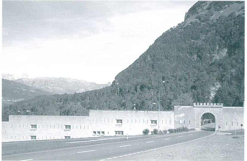
Festungsmauer St. Luzisteig
