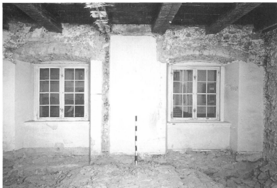
Abb. 24: 1. Obergeschoss, Südwestsicht in Raum 22 des Kernbaues aus der Zeit um 1380; Aufsicht auf das Kreuzgewölbe von Raum 13 und Untersicht an die dendrochronologisch um 1380 datierte, russgeschwärzte Decke
