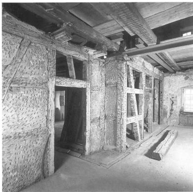
Abb. 25: 1. Obergeschoss, Südsicht in Gang 24; Sichtfachwerk dendrochronologisch datiert mit 1666; linker Teil 1786 anlässlich des Einbaues eines neuen Treppenaufganges um 60 Zentimeter zurückversetzt – der vorspringende Eckpfosten zeigt noch die entsprechenden Zapfenlöcher
