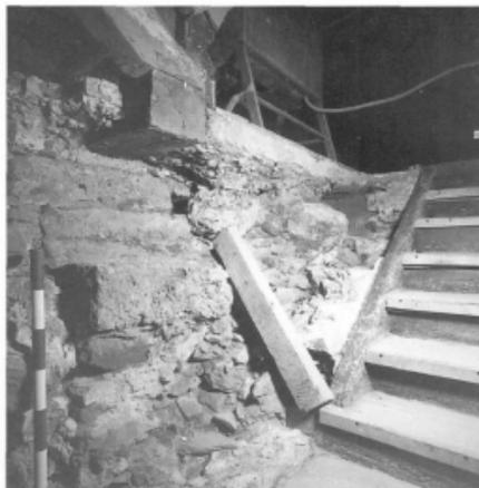
Abb. 9: Links tuffsteinerne Treppenabgang aus der Zeit um 1380 zum Keller 01, archäologisch freigelegt; rechts Holzterrasse von 1666 (bis 1987); oben Raum 15; von Süden gesehen
