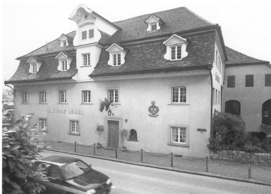
Abb. 1: Der Gasthof Löwen in Vaduz in der spätbarocken Gestaltung von 1786, von Norden gesehen; etwas gedrungene Nordostfassade mit Aufzuggiebel, Haupteingang und rechts davon dem bald 500-jährigen Rundbogen-Fensterchen; ganz rechts die Stallscheune von 1804
