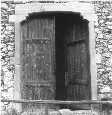
Abb. 48: Scheunentor mit Sandsteingewände in der Nordwestfassade des alten Pfarrhauses nach dem Umbau von 1875
