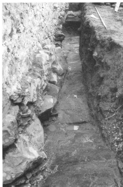
Abb. 20: Blick in die Fundamentlage (A SCH – N-W 1) der Nordwestfassade gegen die Nord-ecke des Hauses. Ungepflegte Fundation auf anstehendem Fels
