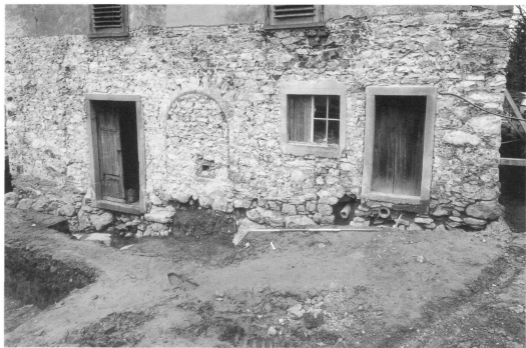
Abb. 18: Kellergeschoss der Nordostseite des alten Pfarrhauses. In der Mitte Rundbogentüre. Links und rechts zwei Türen mit Sandsteingewände (1875), Fenster aus derselben Bauzeit. Am östlichen, linken Sandsteingewände anschliessend zwei übereinandergestellte vermauerte Fenster
