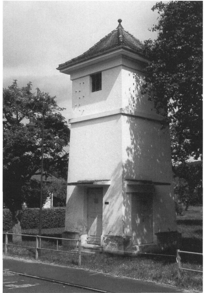
Abb. 12: Ruggell. Transformatorstation «Kirchstrasse» im «Kellersfeld». Das Zeugnis aus den Anfängen der Elektrifizierung des Landes Liechtenstein existiert seit 1997 nicht mehr
