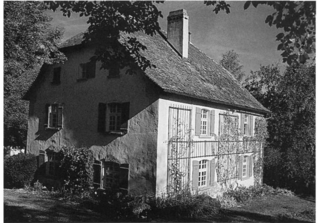
Abb. 3: Schaan. Herrschaftlicher Hof «Gamander». Das in den Jahren 1718/20 errichtete Gebäude steht seit 1951 unter Denkmalschutz
