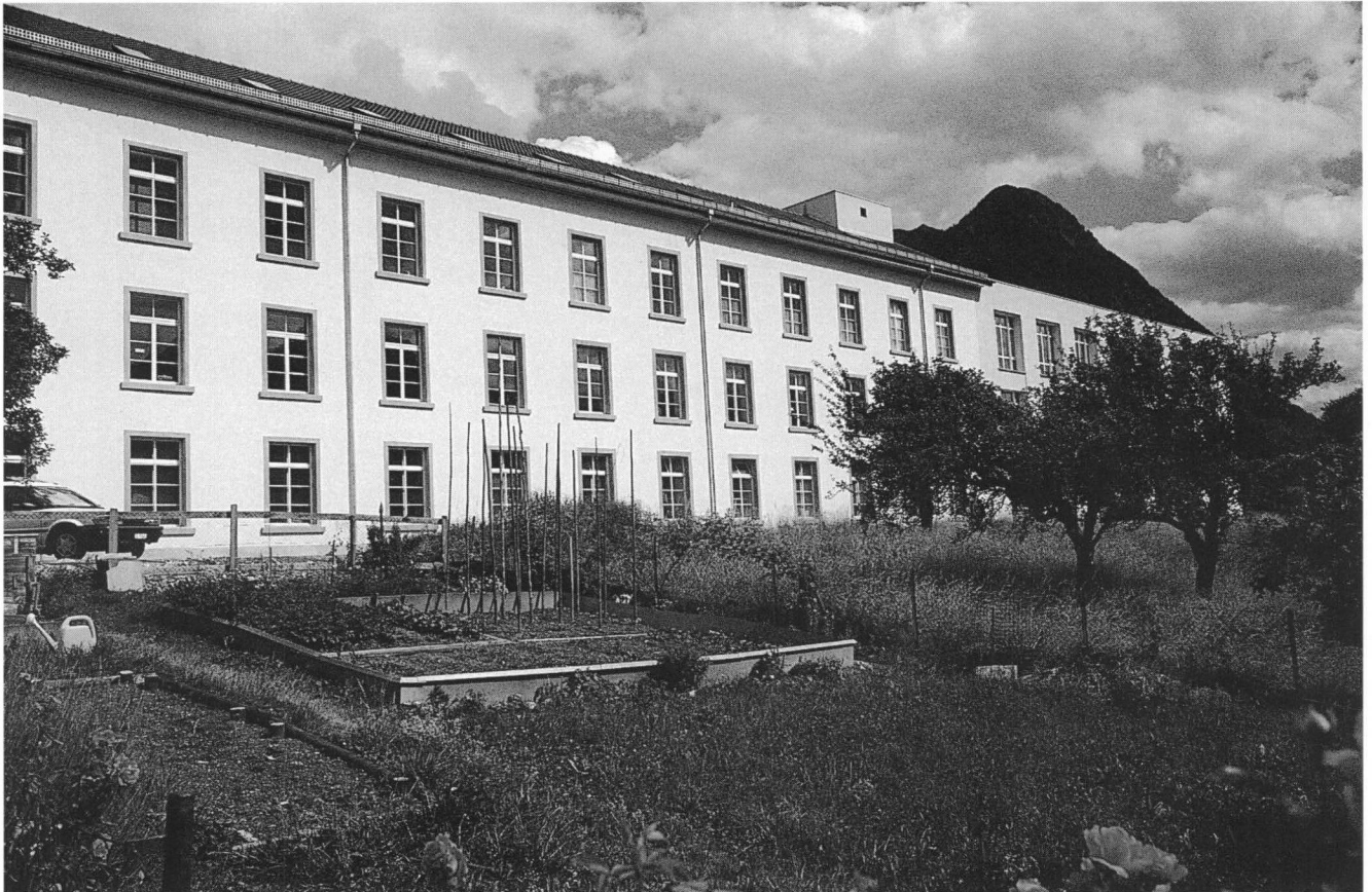
Abb. 1: Triesen. Stillgelegte Weberei der Firma Jenny, Spoerry & Cie. Westfassade des 1863 erbauten Haupttrakts nach der Aussensanierung
