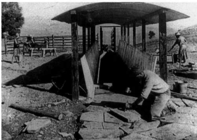
Bauarbeiten in Mariannhill (Südafrika)
