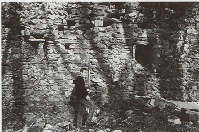
Abb. 8: Fläsch/Balzers, Burgruine Grafenberg (Mörderburg). Innenansicht der östlichen Palasmauer im Frühjahr 1993.
