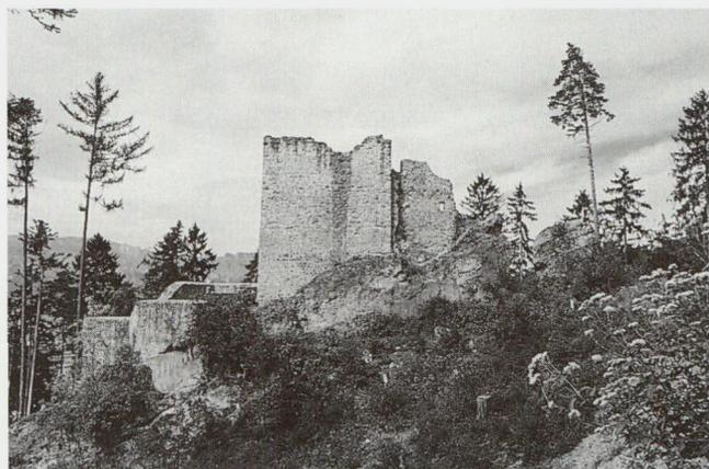
Abb. 27: Vaduz, Burgruine «Wildschloss/Schalun». Schräggestellte Betonstützen dienen der Felssicherung. Aufnahme nach Abschluss der Arbeiten im Sommer 1993.
