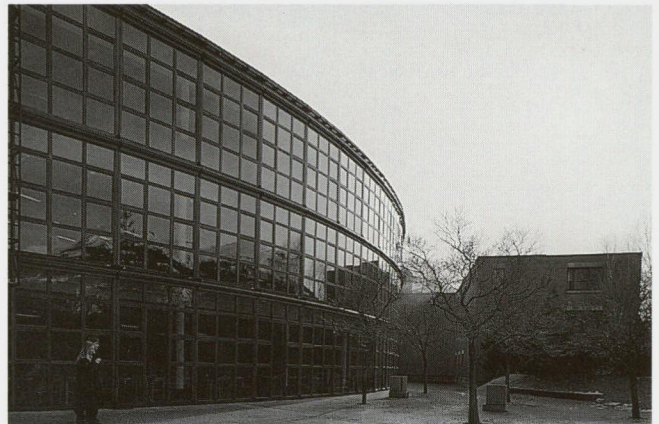
Abb. 25: Das Schulzentrum Mühleholz in Vaduz steht als Eckpfeiler modernen Bauens im Fürstentum Liechtenstein seit 1992 unter Denkmalschutz. Blick auf den Klassentrakt.
