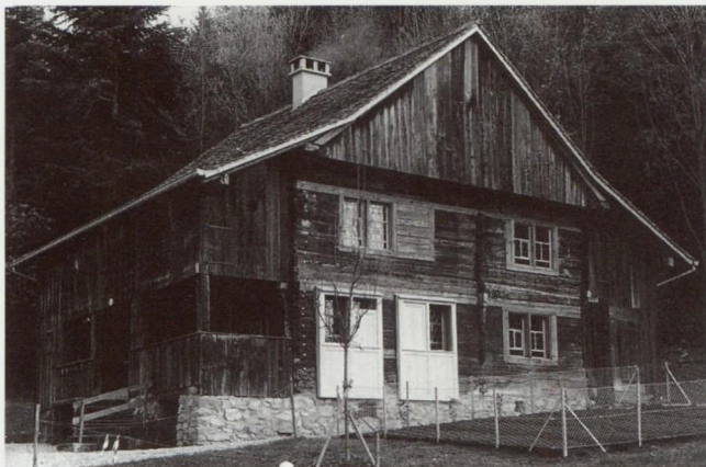
Abb. 18: Schellenberg. Das Wohnhaus Nr. 12 vor Beginn der Translozie- rungsarbeiten. Aufnahme vom Frühjahr 1990.
