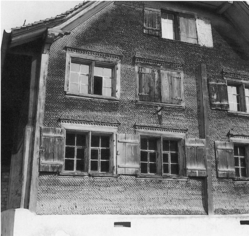
Abb. 16: Wohnhaus-Westfassade; schmucker Rundschindelschirm, Sprossenfenster und Klappläden des 19. Jahrhunderts; Dachstuhl mit ziergesägten Flugsparren-Schuhen von 1827d.
