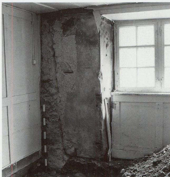
Abb. 45: Wohnhaus 47, Stube, Südwand; Baunaht; rechts höher fundierte, verputzte Mauer des 18. Jahrhunderts mit Negativen eines gespundeten Dielenbodens und hölzerner Ostwand; links Mauerwerkerverweiterung von 1862; Täfer und Fenster von 1862
