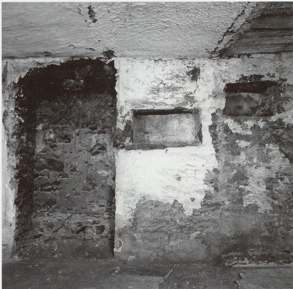
Abb. 14: Wohnhaus 46, Küche von 1510; Westwand mit Haustür; links oben spätere Tür ins Obergeschoss des Westanbaues
