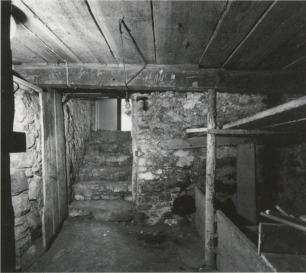
Abb. 11: Wohnhaus 46; Südeinsicht in den Keller unter der Stube von 1510, mit Treppenabgang aus der Küche
