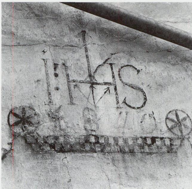
Abb. 10: Wohnhaus 46, Westfassade; in Englisch-rot aufgemalte Jahrzahl «1840» über stilisiertem Schiff; die Malerei ist mit einem Nagel in den noch feuchten Putzmörtel vorge-zeichnet
