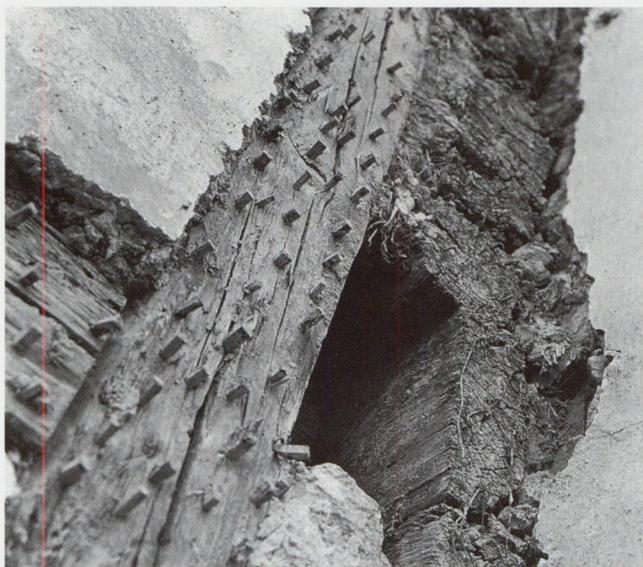
Abb. 9: Wohnhaus 46, Südfassade; Vormauerung 1834/40 in Lehmwickel-Fachwerk, zur Putzhaf-tung mit Holznägeln be-spickt
