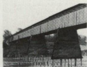
Die alte Bänderer Rheinbrücke kurz vor ihrem Einsturz. Das Bild belegt die Senkung der Rheinhöhe durch die Ausbaggerungen in den Jahren 1953 bis 1973. Zur Fundierung der fünf Joche waren Holzpfähle, die vorne mit Eisenschuhen verstärkt waren, in den Untergrund geschlagen worden.
