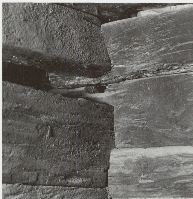
Abb. 41: Obergeschoss, Westecke Innenansicht, 1793/94, unsorgfältiges Wiedersetzen des Blockbaues; das Holzwerk ist vom Küchenrauch stark verpecht.
