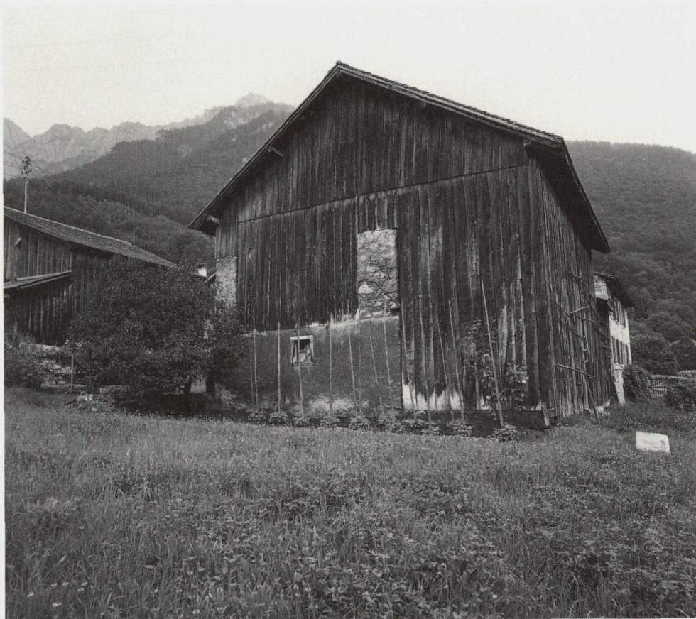
Abb. 51: Stallscheune Hintergasse 37 von 1890; Westansicht
