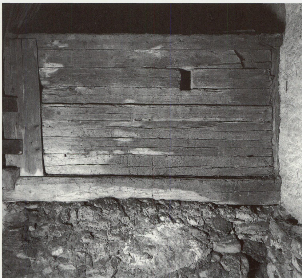
Abb. 47: Stall Hintergasse 35; südwestliche Wand in Ständerkonstruktion und Kantholzfüllung
