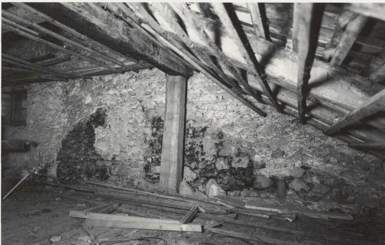
Abb. 46: Dachgeschoss; nordwestliche Giebelmauer mit älterer Dachschräge und starker Verpechung durch Küchenrauch; Unterlattung für Maistrocknung
