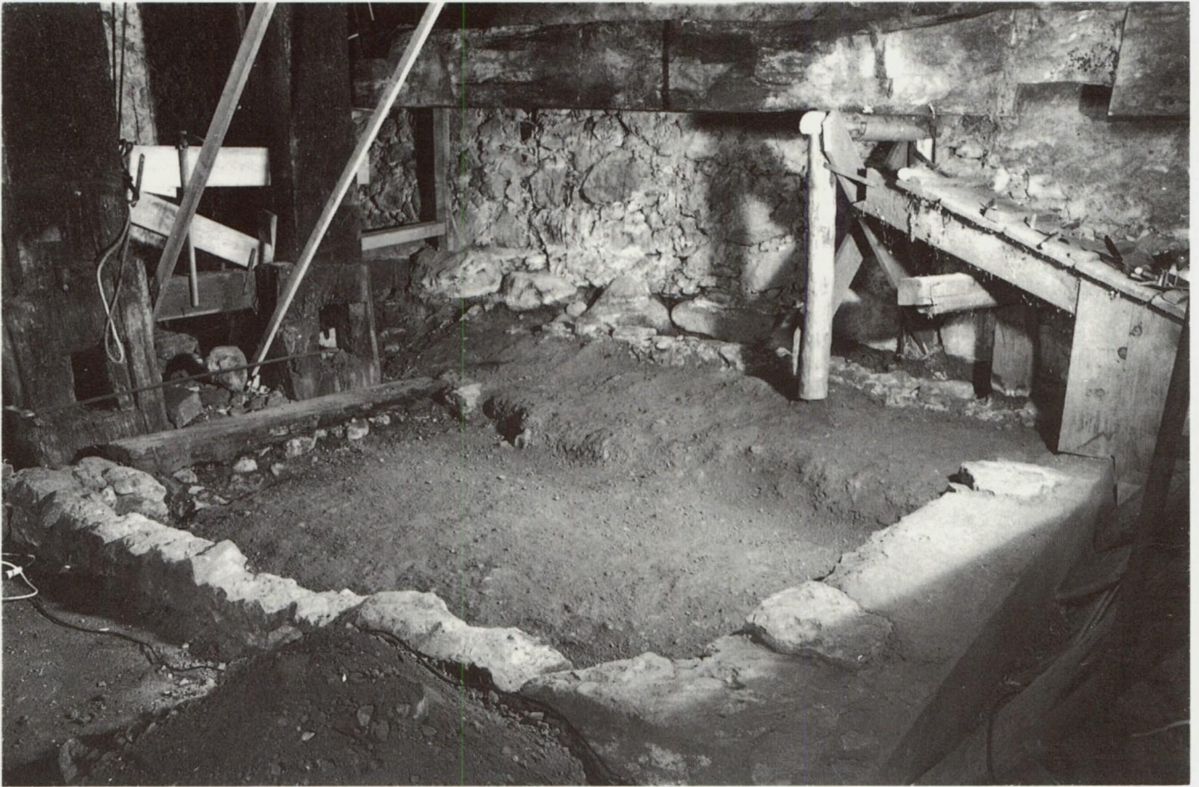
Abb. 2: Der Torkelunterbau nach dem Abtragen der Kellerschicht.
