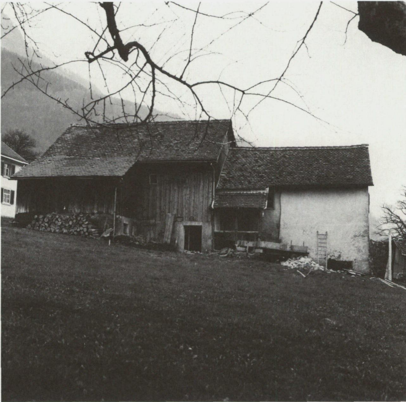
Abb. 23: Haus Nr. 52, Nordfassade
