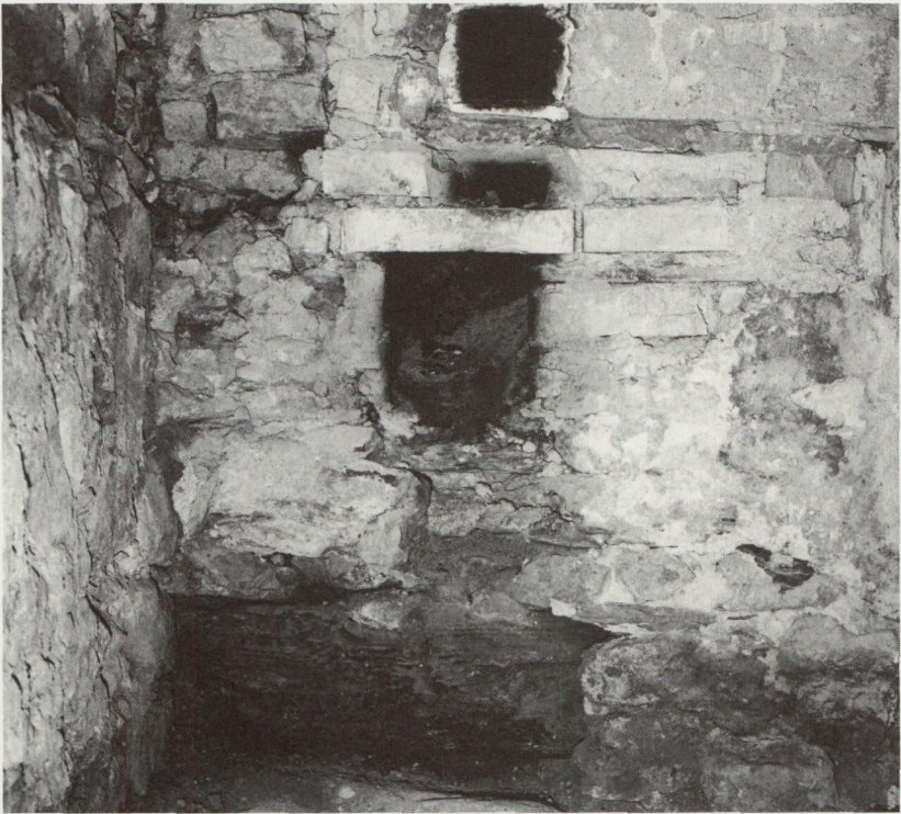
Abb. 4: Küche, Südwest-Ecke und Feuerwand in Massivmauerwerk, unten die unterste Bohle der einstigen Blockwand.
