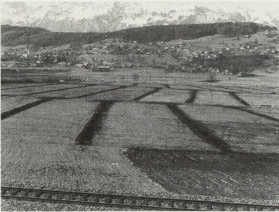
Abb. 129: Zweite Drainage im «Maurer Riet» im Februar 1984
