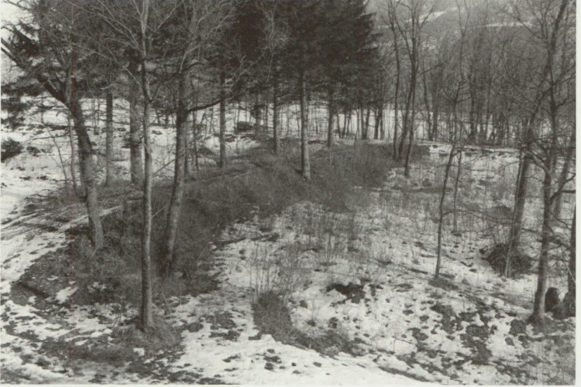
Abb. 9: Kolmations-System zwischen Rheindamm und Binnendamm. Zwischen den beiden Dämmen konnte einst durch ein Schleusensystem mit Sedimenten befrachtetes Hochwasser in den Dammwischenbereich eingeflutet und kolmatiert werden. Das Wasser wurde über ein Vorflutsystem wieder in den Rhein zurückgeführt.
