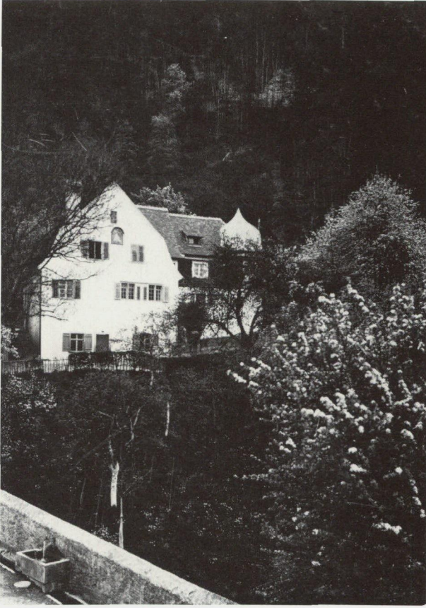
Abb. 75 Vaduz, Haus Beckagässle Nr.10. Zweiter Umbau 1915.
