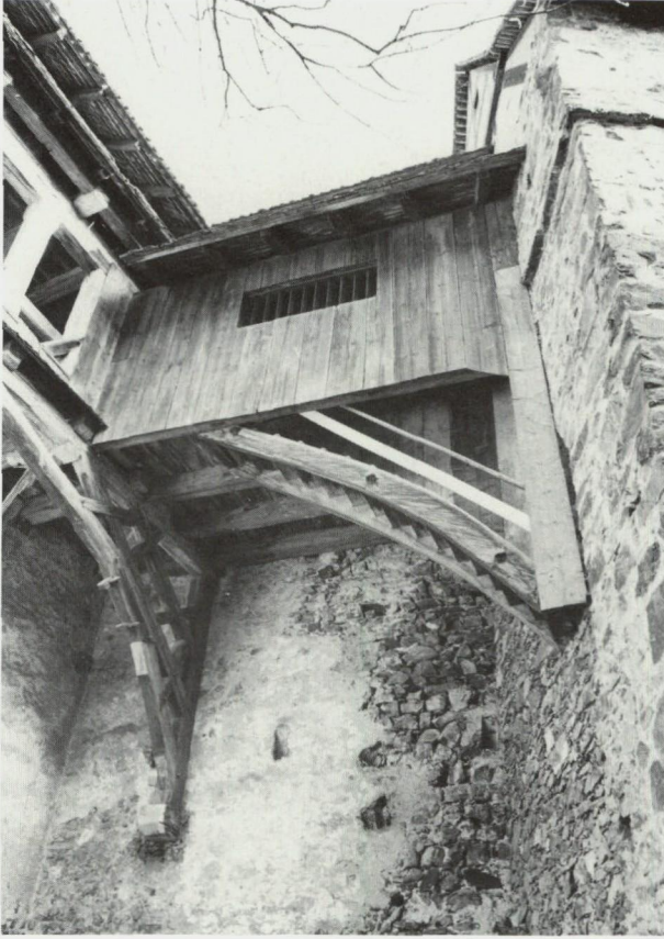
Abb. 61 Burg Gutenberg in Balzers. Obere Bogentreppe zum Wehrgang.
