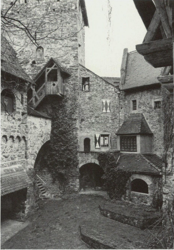
Abb. 59 Burg Gutenberg in Balzers. Hofansicht, Süd- u. Westtrakt.
