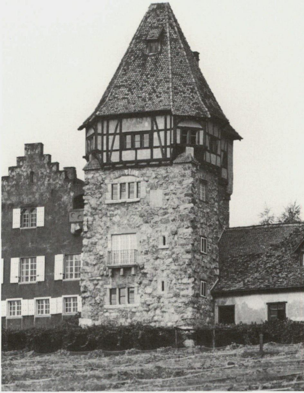
Abb. 33 Rotes Haus. Turm. SW-Ansicht.
