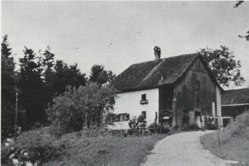
Der Ferdi-Büchel-Hof in Gamprin, erbaut ca. Mitte des 17. Jahrhunderts.
