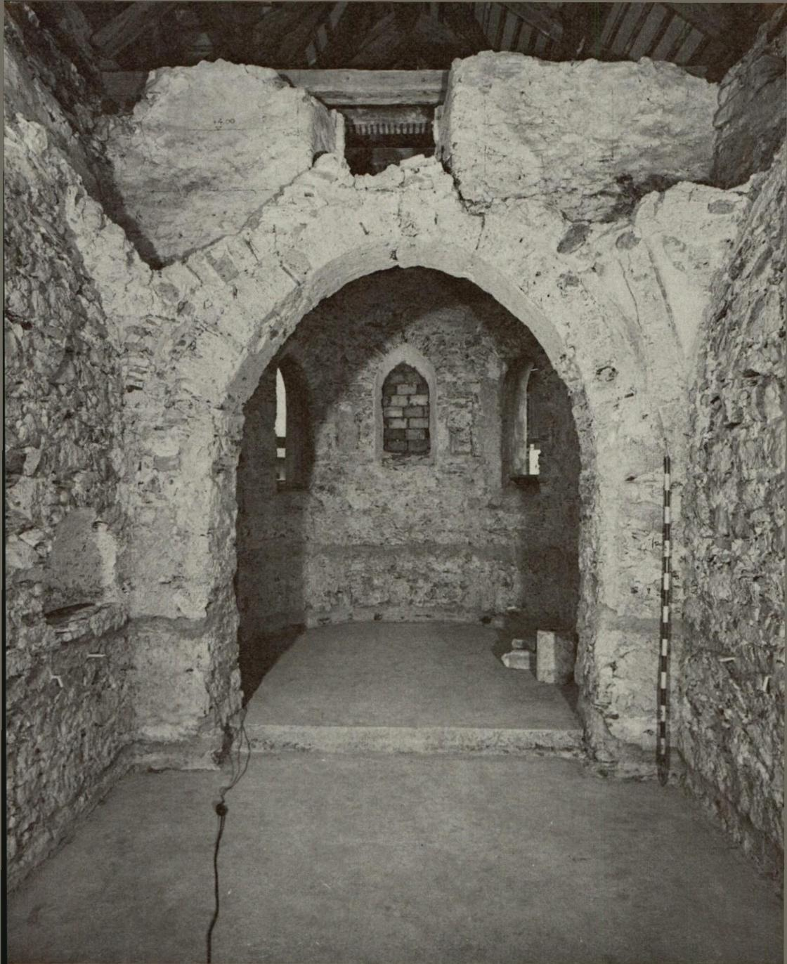
10 Blick aus dem Schiff gegen das Chor. Ursprüngliche Giebelwand der Kapelle und Öffnung gegen den Estrich und Gewölbeansätze im Schiff
