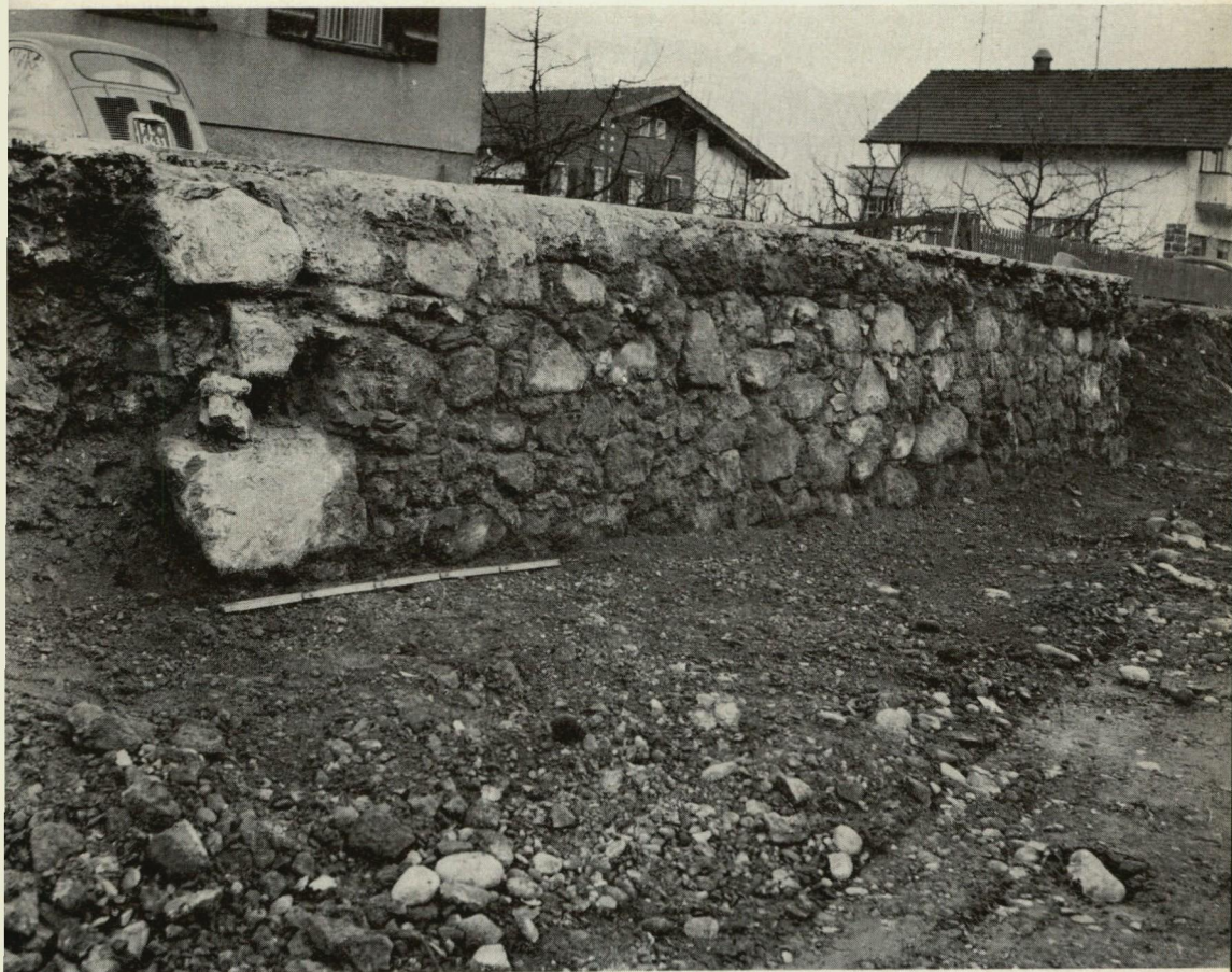
Abb. 2 Blick gegen die Westseite der Mauer. Im Hintergrund in der Strassenböschung 120 cm starke Rüfeschutttauffüllung. Darunter 1. Strassen-niveau mit 55 cm starker Kofferung.
