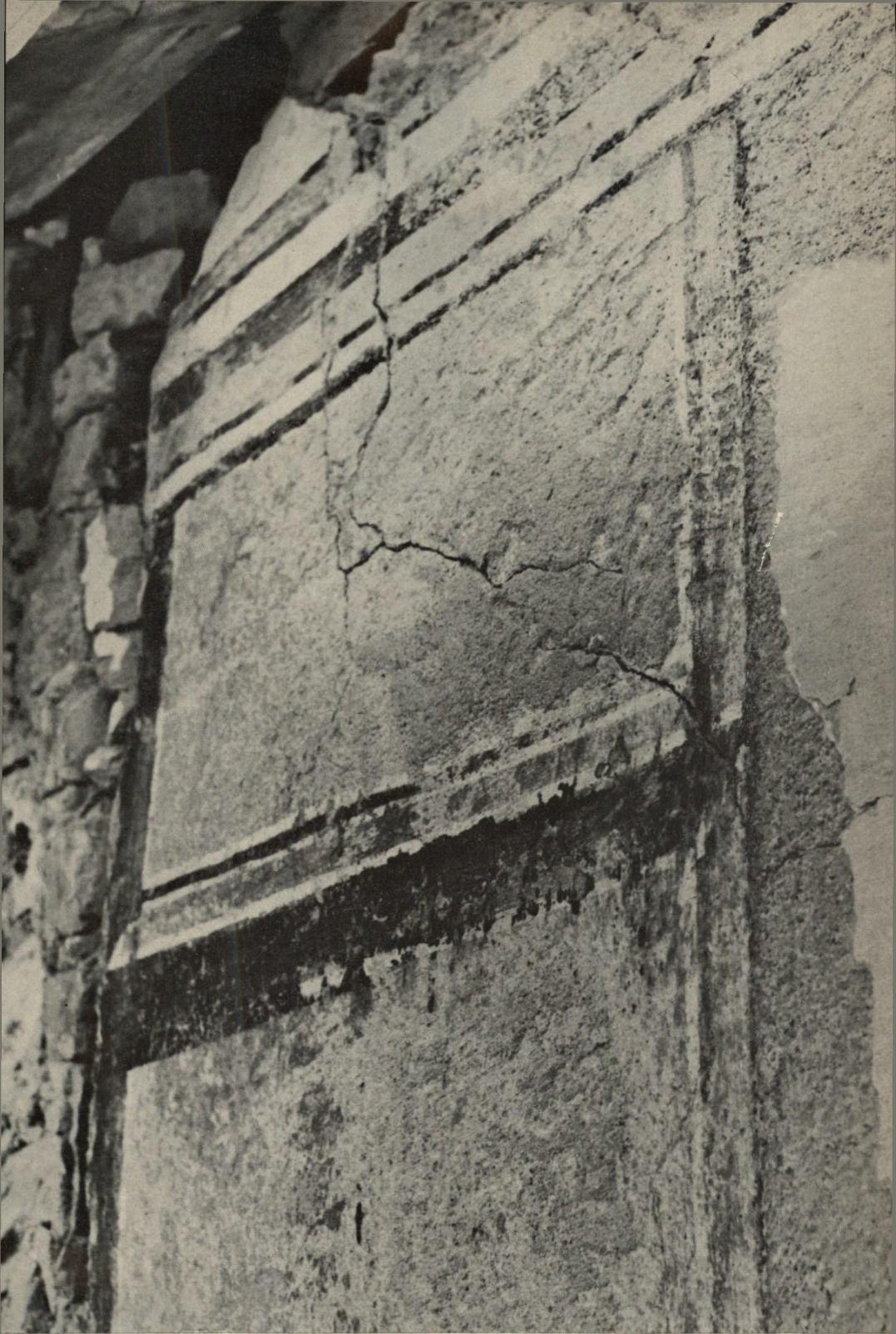
Abb. VI. Eckmalereien an der ehemaligen Nord-Westecke auf der 2. Putzschicht. Nach dieser Malerei wurde die Fassade rekonstruiert.
