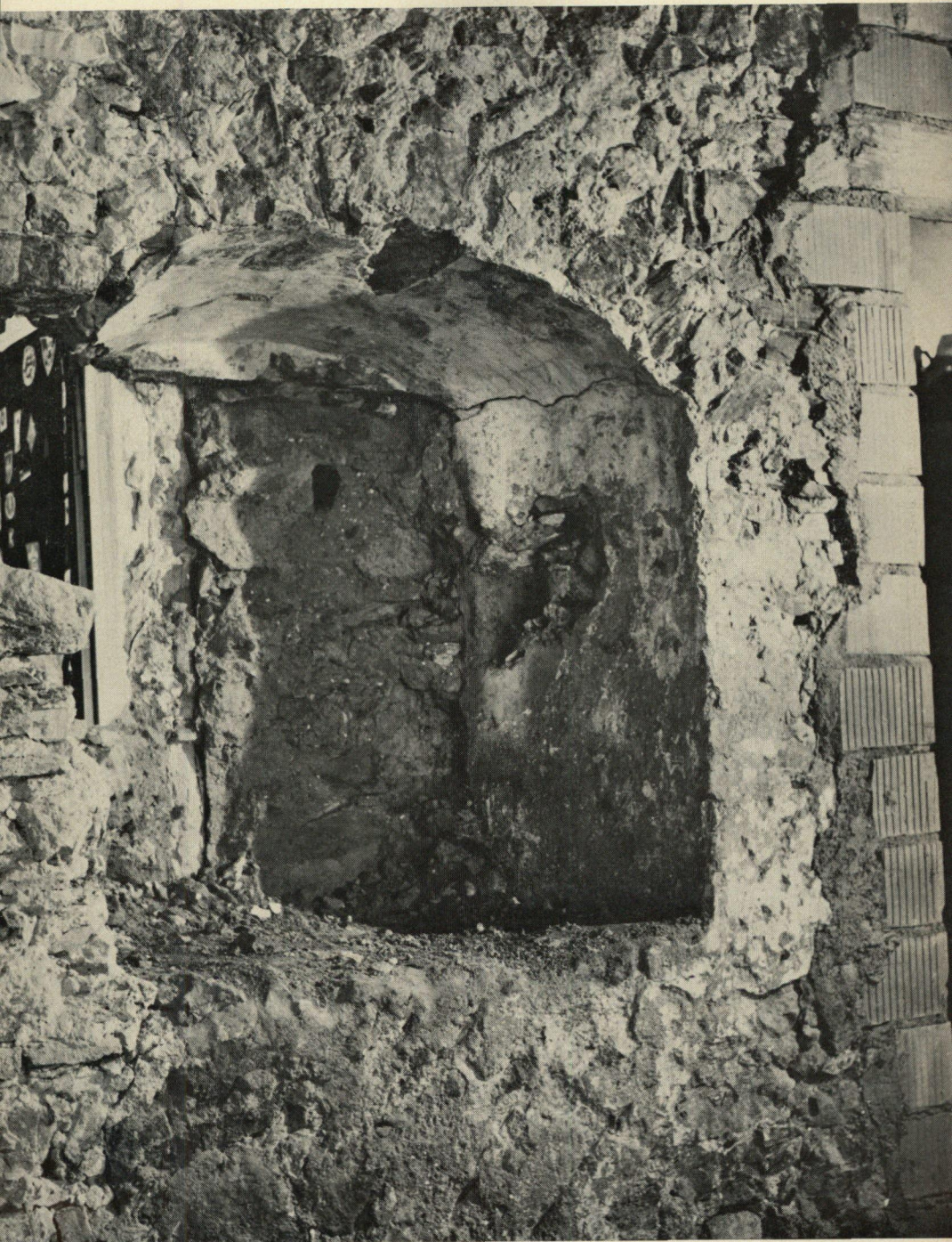
Abb. IV. Fensteröffnung im Gang an der Nordwand des 1. Obergeschosses
