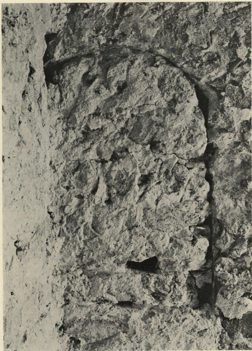
Abb. II. Vermauerte Nische im Süd-West-Zimmer des Erdgeschosses (wieder zugemauert)
