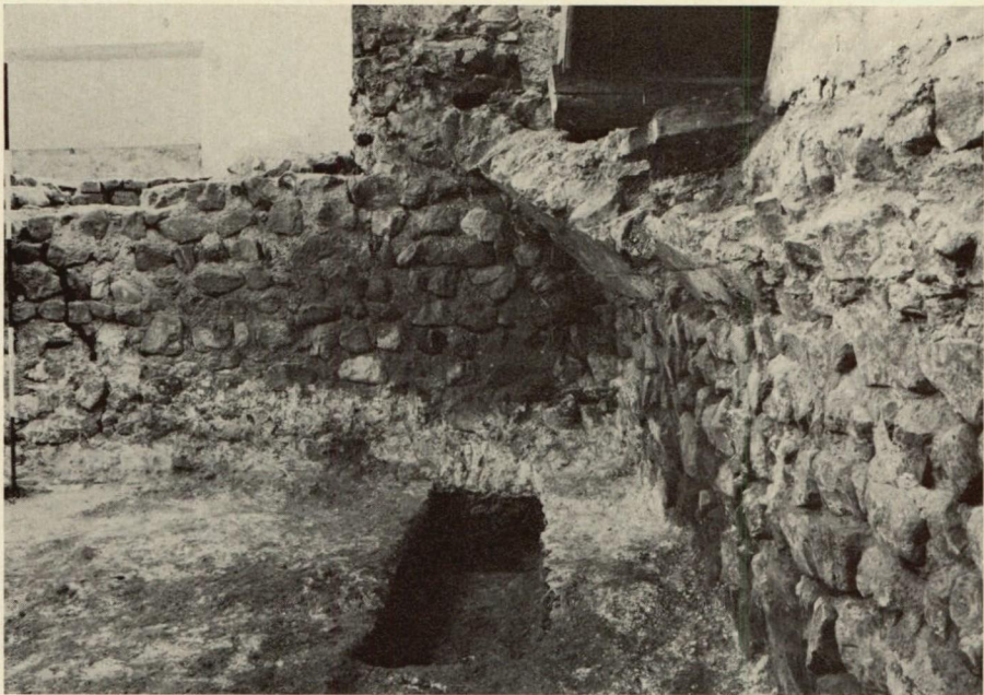
Abb. 3. Gewölbeansatz im Keller I mit Sondiergraben.
