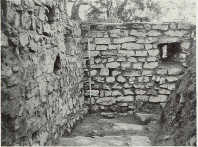
Abb. 23 Nordostecke des Raumes 4
