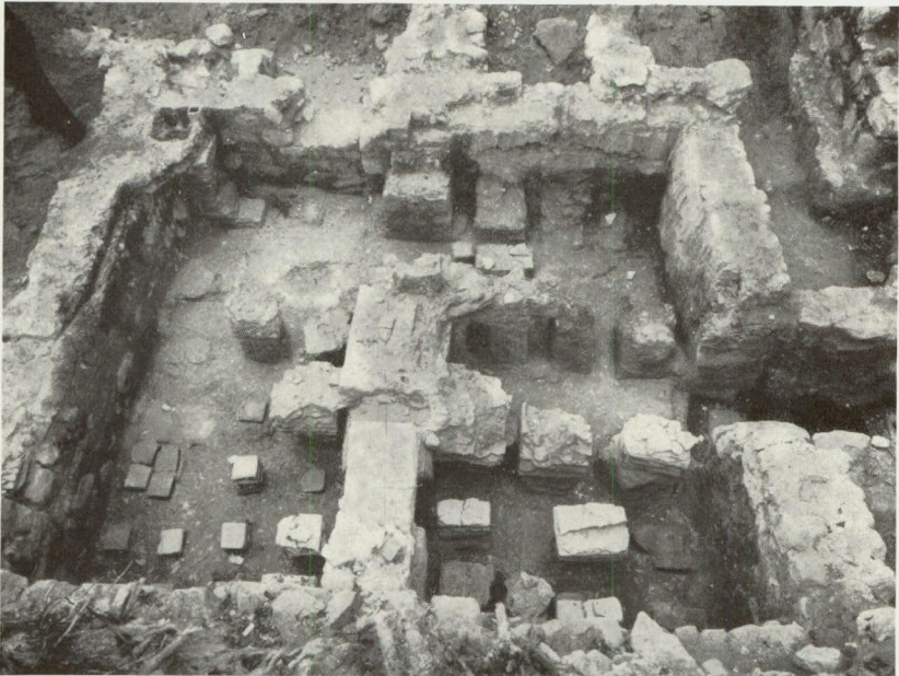
Abb. 15. Das Hypokaustum, rechts Warmbad, links Laubbad ganz rechts Heizkanal
