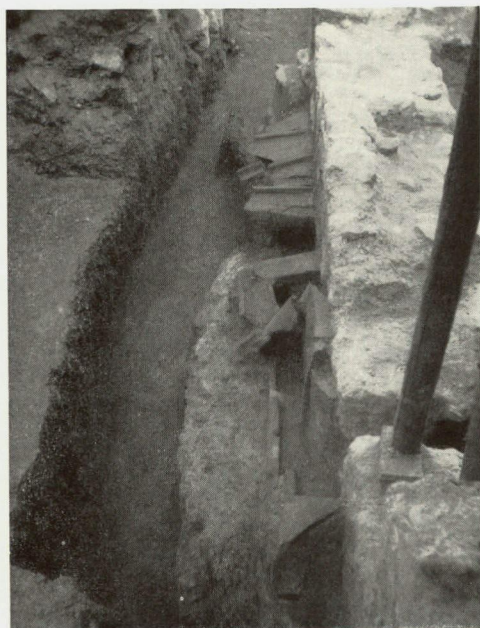
Abb. 12. Kanalablauf aus Dachziegeln
