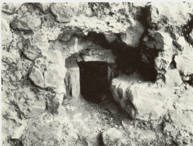
Abb. 13. Wasserleitungskanal durch die Ostmauer (Innenseite)
